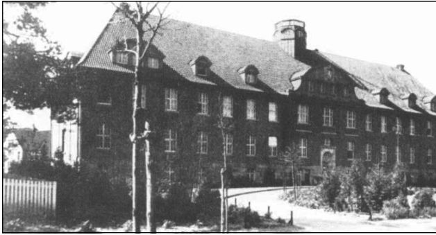
Hauptgebäude der Westfälischen Provinzialheilanstalt, in der die Räume für die Verwaltung eingerichtet wurden. Hier hatte Hermann Simon sein Arbeitszimmer. (Fotografie um 1925, aus: Ludwig Schluckebier: Wie im neuen Gütersloh gebaut wird . Berlin 1925, S. 57).
